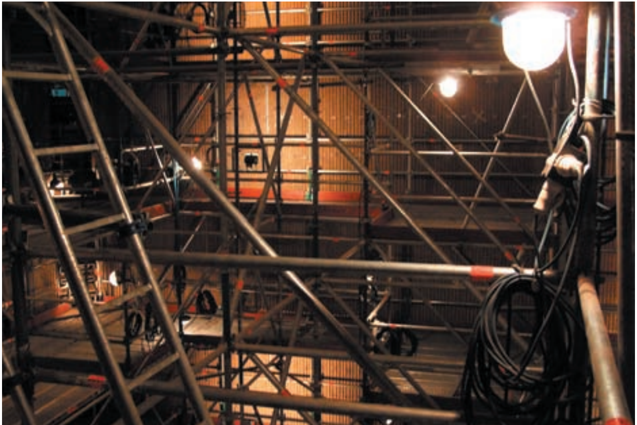
De eerste grote opdracht voor 2rent betref verschillende werkzaamheden voor de stop bij de EPZ-kolencentrale in het Zeeuwse Borssele.
